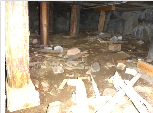
Krypgrund, ingång vid pannrum.
