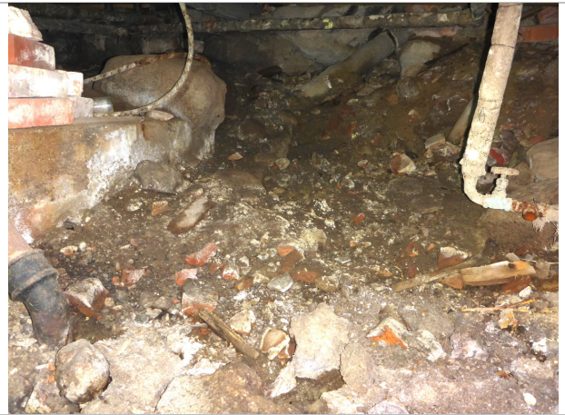
Krypgrund, ingång i hall källare.
