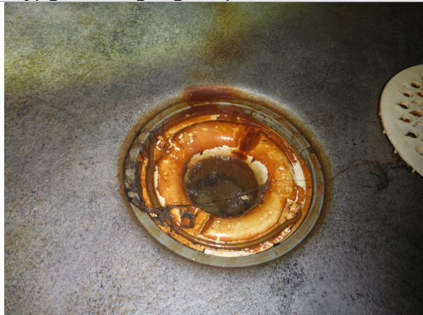
Dusch öv, golvbrunn.
