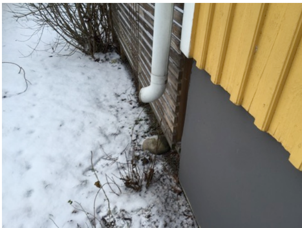
Stuprör på baksida avslutar invid hus
