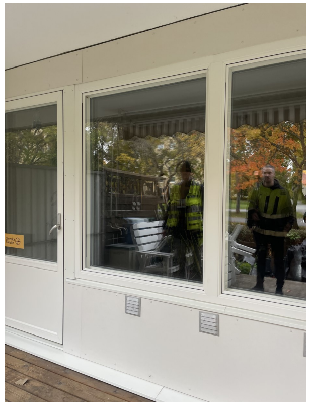
Bild från besiktning av de nya fönstren.
